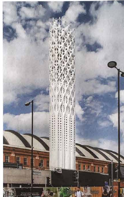
LEICHTGEWICHT. Der „Tower of Light“ von Tonkin Liu Architects ragt 40 Meter in Manchester in die Höhe. Die Fassade wurde aus dünnen Stahlplatten gefaltet und gebogen. Als Strukturvorbild dienten unter anderem auch Muschelschalen.
